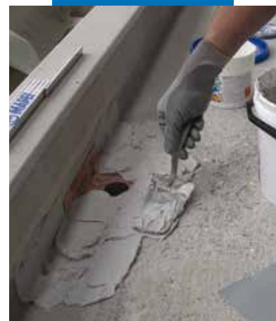
Rasatura successiva con Adesilex PG4
