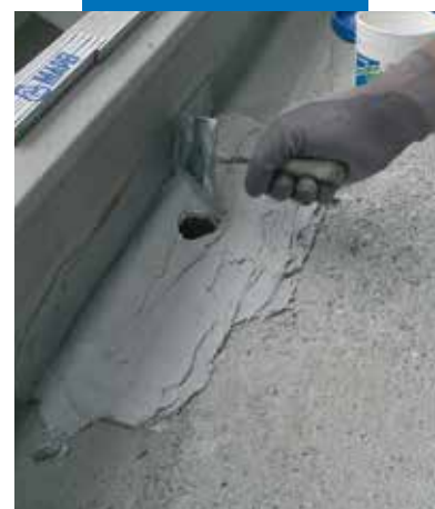
Copertura finale con Adesilex PG4
