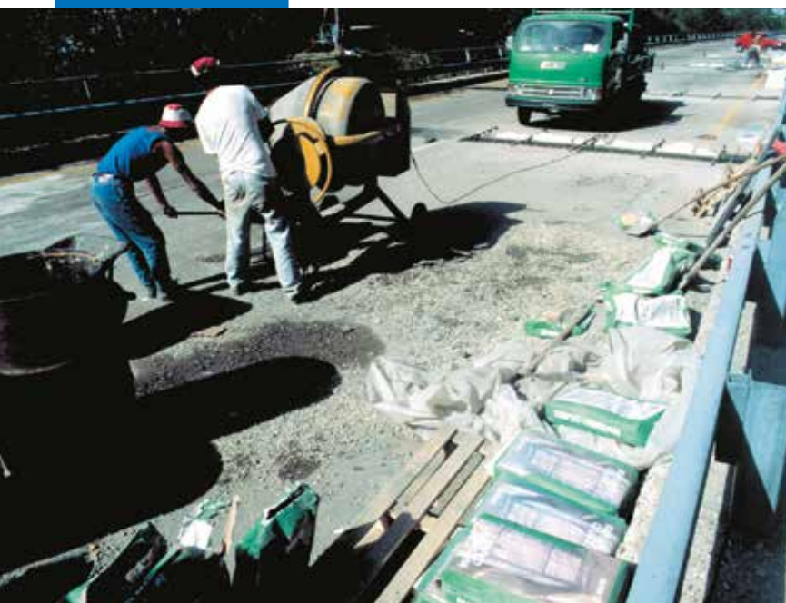
Rifacimento di giunti stradali
