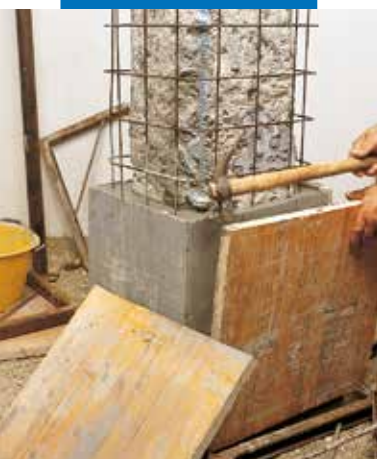
Disarmo da cassero in legno
