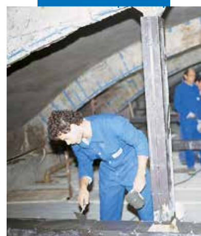
Getto con Mapegrout Colabile in cassero metallico
