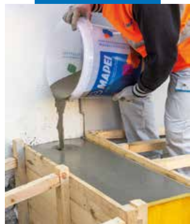
Ripristino con aumento di sezione di un muretto in calcestruzzo con Mapegrout Ancora & Ripara
