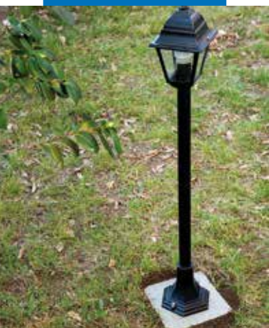
Ancoraggio di un lampione con Mapegrout Ancora & Ripara
