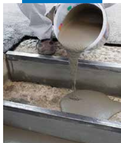
Ripristino di un gradino di una scala in calcestruzzo con Mapegrout Ancora & Ripara
