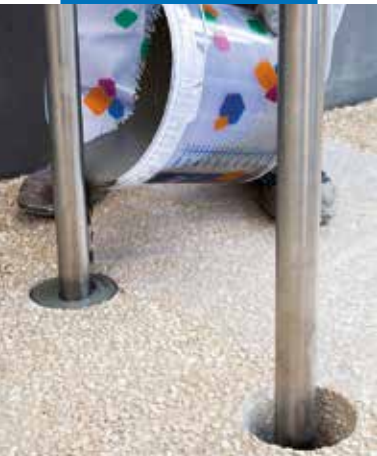
Ancoraggio di arredo urbano con Mapegrout Ancora & Ripara
