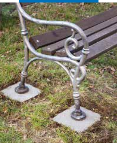
Ancoraggio di una panchina con Mapegrout Ancora & Ripara
