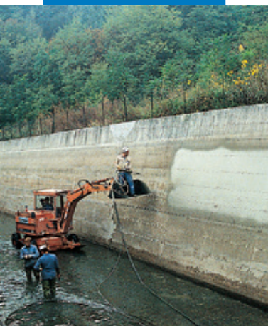
Applicazione a spruzzo di Planiseal 88 in canale idroelettrico
