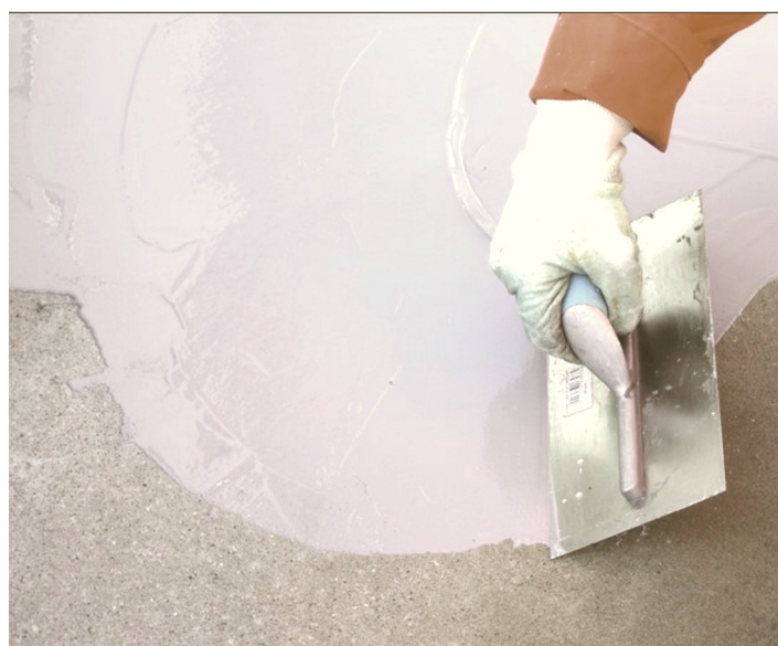
Figura 2 - Rasatura su calcestruzzo.
