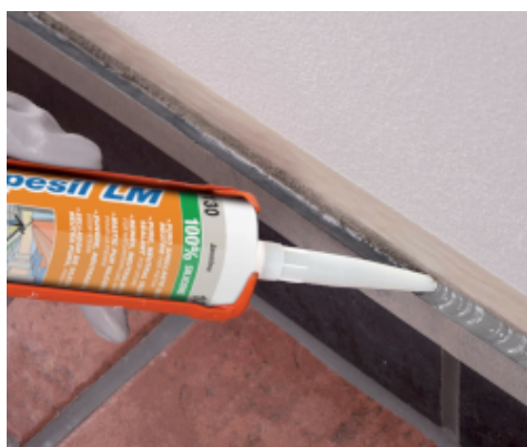
Sigillatura di rivestimento in pietra in interno
