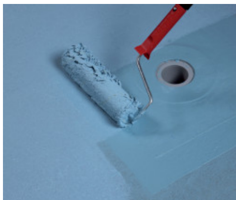
Applicazione a rullo della seconda mano di Mapelastic AquaDefense
