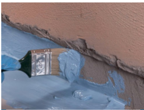
Stesura a pennello di Mapelastic AquaDefense nel raccordo parete/pavimento, prima dell'applicazione di Mapeband
